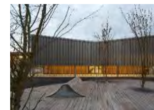
Site scolaire Charlemagne à Attigny (08), 2014
