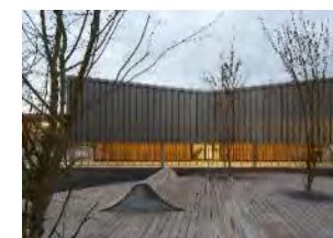
Site scolaire Charlemagne à Attigny (08), 2014
