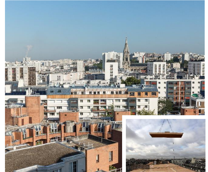
6 logements collectifs en surélévation Lair et Roynette architectes
