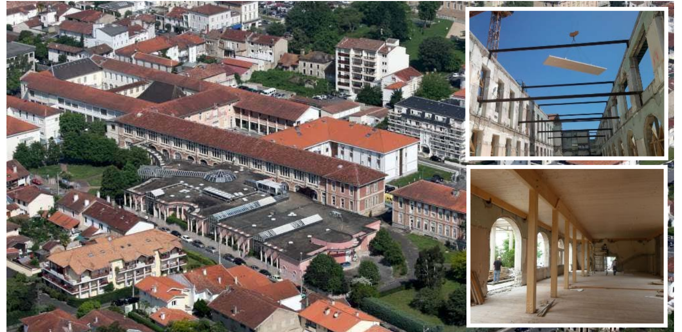
Restructuration du centre hospitalier SARL Coherence Dax (40)
