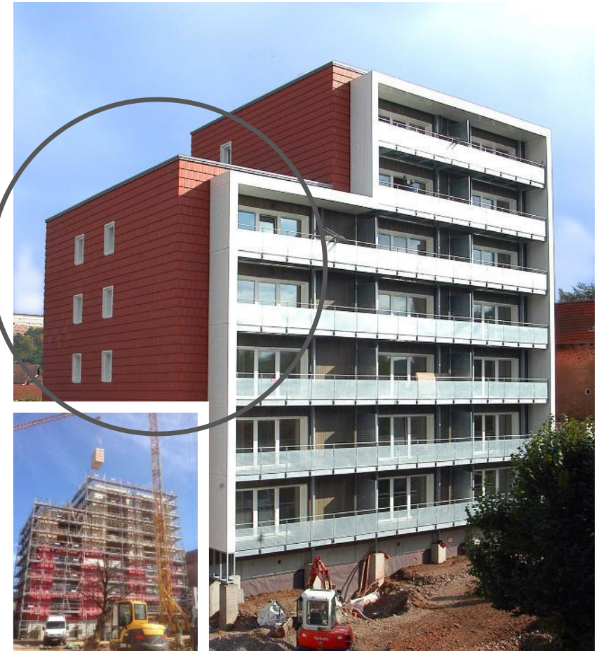
26 logements sociaux en R+7 ASP architectes
