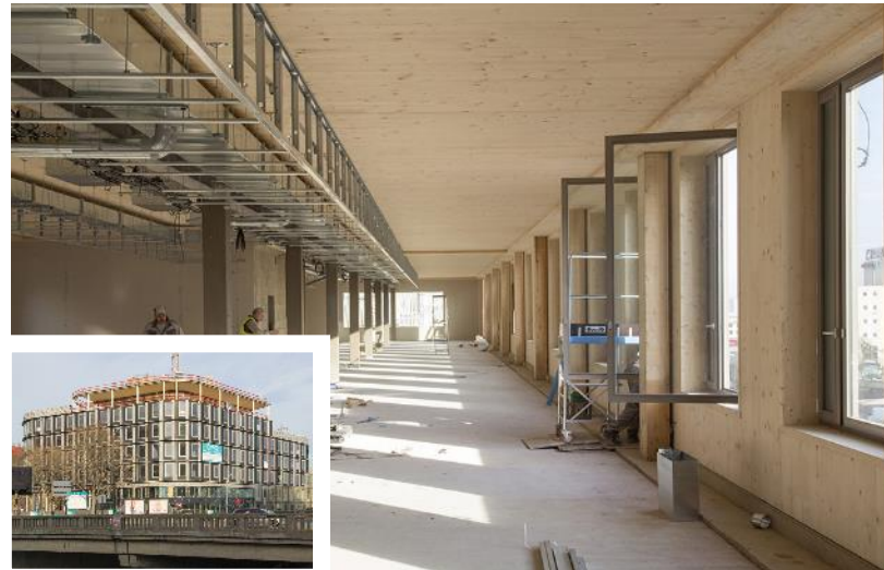
Immeuble de bureaux Art & Build Paris (75)
