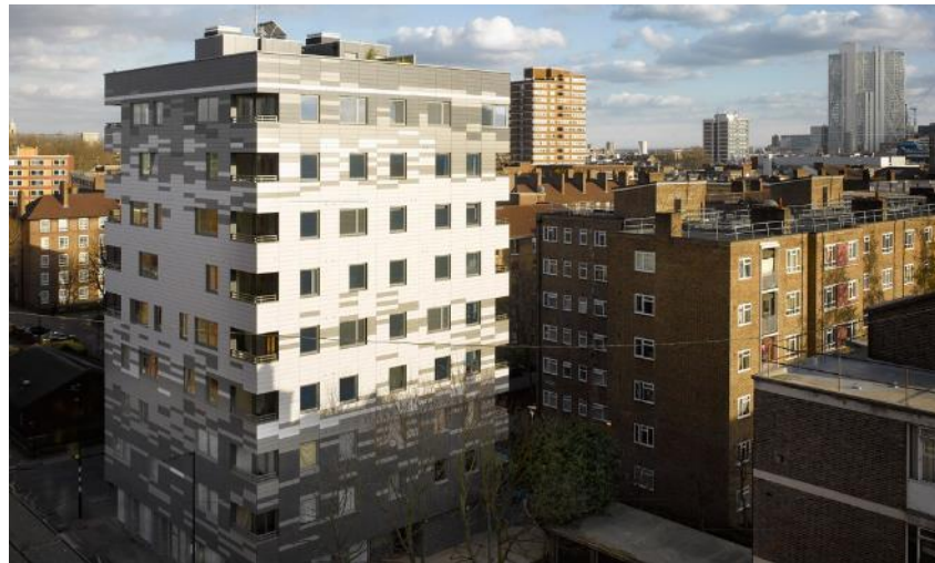
Immeubles de logements R+8 Waugh Thistleton architects
