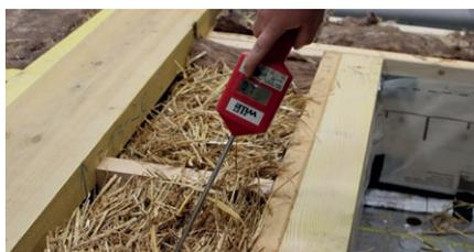
**Le taux d'hygrométrie** au cœur des bottes doit être mesuré et contrôlé.
