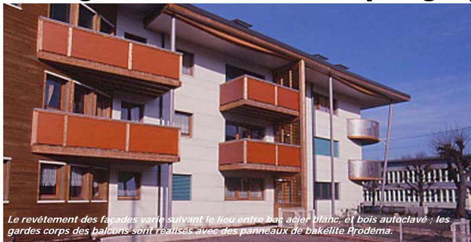
Le revêtement des façades varie suivant le lieu entre bac acier blanc, et bois autoclavé ; les gardes corps des balcons sont réalisés avec des panneaux de bakélite Prodéma.
