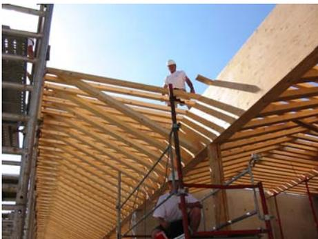
La structure bois s'équilibre autour d'un porteur en lamellé collé qui reprend les pièces horizontales et les contres fiches, de part et d'autre.
