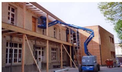
Le bâtiment contigu à l'extension et flanqué d'une desserte extérieure en bois, permet d'accéder aux classes ; on remarquera que les gardes corps initialement calés à 1m de hauteur, ont été rehaussés à 1,2m, sur la demande du maître d'ouvrage, pour la sécurité des élèves turbulents, et de plus en plus grands.
