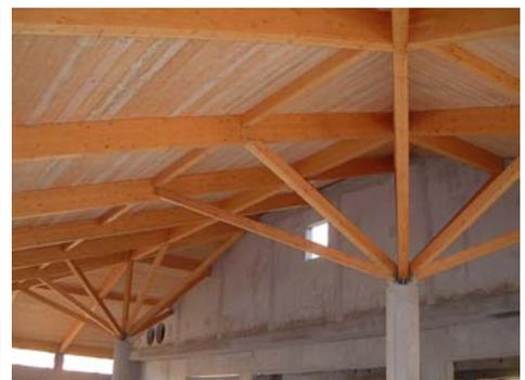
▲ La charpente est reprise par des contre-fiches, qui forment une arborescence à partir de poteaux béton.
