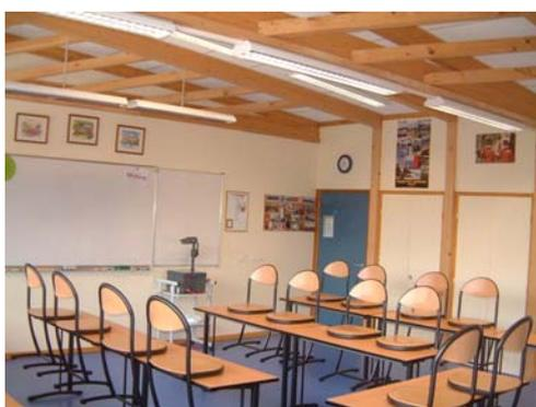
Le bois reste présent sur les murs, avec des montants verticaux qui participent à la descente de charges, et au plafond avec la charpente ap- ▲
