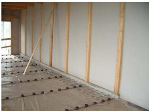
Le plancher est constitué d'un système bois béton connecté (Sylvabat) qui permet une forte rigidité des planchers, le niveau coupe feu requis et l'affaiblissement acoustique. ▲
