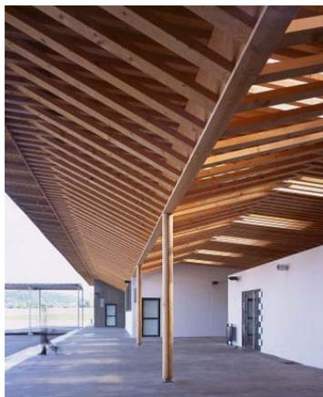
Le bois est « tissé » en charpente apparente, utilisant des petites sections, en fiches et contrefiches. Il est apparent dans les classes et dans les dessertes extérieures
