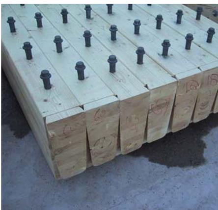
▲ *Le plancher est constitué d'un système bois-béton collaborant, avec des connecteurs constitués par d'anciens tire-fonds de voies ferrées reconvertis.*
