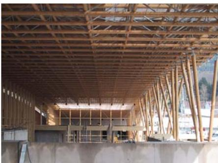
▲ *Les cloisonnements fumée ont été négociés chez les pompiers, contre des désenfumages mécaniques mis en œuvre dans deux secteurs, et dont les machineries sont au-dessus du toit. Ce qui a permis de traiter la continuité du volume, et le principe de boîtes désolidarisées sous la nef*
