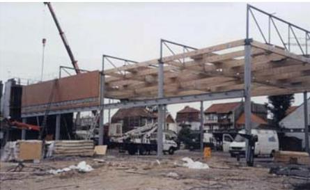
▲ La structure est constituée de poteau en béton, sur lesquels est posée une charpente mixte, qui allie bois et métal.
