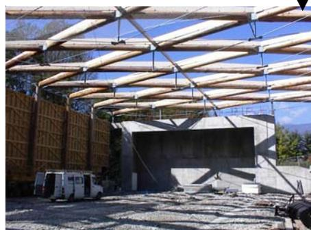
**Les murs sont constitués d'une ossature bois, incluant un isolant, et un bardage bois extérieur comme intérieur.**
