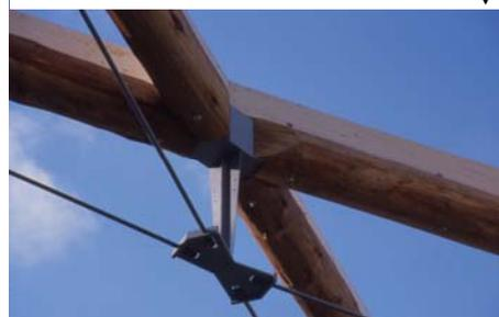
**La sous tension est assurée par des cables, écartés de la structure par uneentretoise métallique.**
