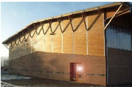
Les fermes sont constituées de 2 pièces de lamellé collé, assemblées par une ferrure et sous tendues par un double câble.
