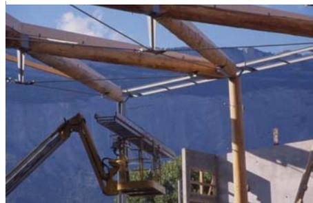
**Les troncs sontn en Douglas; ils ont été écorcés à la main, et ont subi un lavage avec un appareil de projection d'eau à haute pression.**
