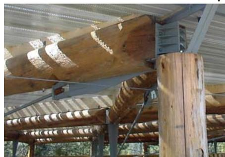
**La forme en éléments croisés de la structure assure son constreventement dans le plan horizontal.**
