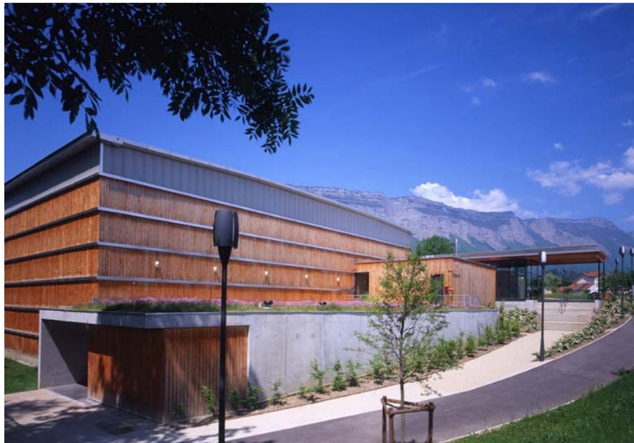
*Le gymnase est recouvert d'un bardage en Douglas naturel, posé en vertical, et recouvert par des joints horizontaux.*
