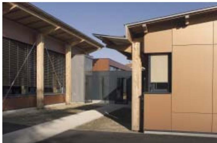
▲ Chez Tectoniques, il est fréquent de rendre autonomes la structure porteuse et les cloisonnements intérieurs. Il n'était pas absolument nécessaire d'avoir les pieds de portiques à l'extérieur. Cependant ils rythment le premier plan de la façade. Au second plan, on trouve les percements là où ils sont utiles, d'où la dissymétrie est-ouest : les pare-soleil extérieurs qui correspondent exactement à la demande du point de vue, sont gérés au fil de l'année en fonction des besoins de protection.
