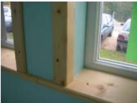
▲ Les menuiseries extérieures sont des blocs baie en PVC avec volet roulant, vitrages peu émissifs et lame argon. Positionnés au nu extérieur, ils permettent une animation intérieure.
