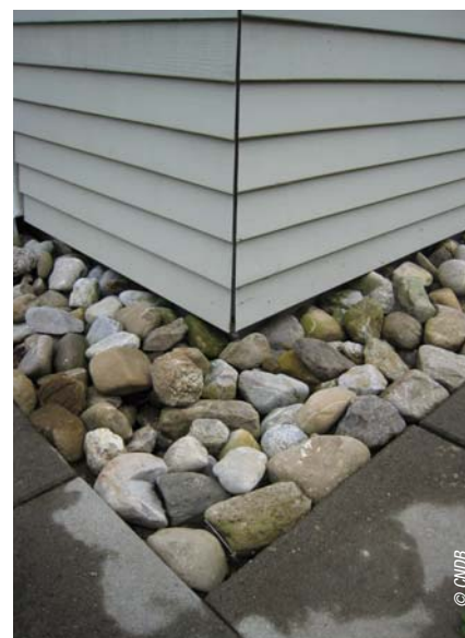
Lames horizontales aboutées avec joint de ventilation.
