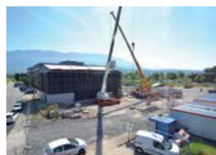
Livraison de 2 modules par convoi exceptionnel
