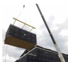
Pose par grue mobile
