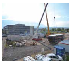
Fin d'assemblage du bâtiment
