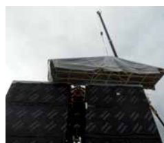
Installation de la toiture provisoire
