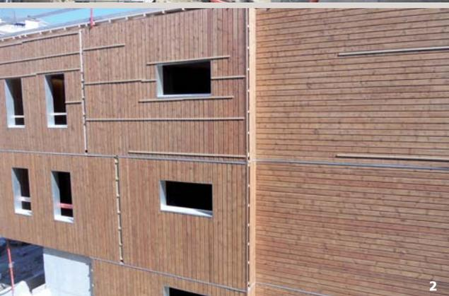
1\_Le levage des panneaux ossature bois. 2\_La pose en préfabrication de panneaux avec du bardage vertical est plus facile qu'avec du bardage horizontal. 3\_Le moment où l'on réalise la toiture terrasse est toujours délicat jusqu'à la pose de l'étanchéité. 4\_La fibre de bois prend place entre les montants d'ossature.
