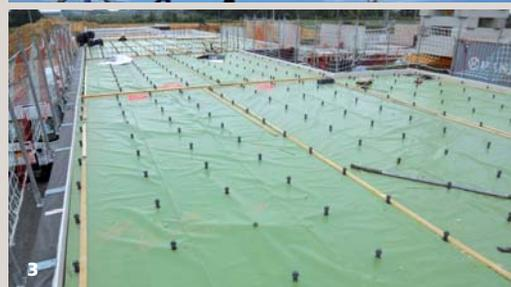
1 Les bâtiments sont ancrés sur sous-sol accueillant les garages. 2 Levage d'un panneau de mur extérieur. 3 Plancher bois béton avec connecteurs.
