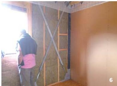
**1** Pose des premiers murs ; nous remarquons le pare vapeur en attente au droit du plancher et la maillière qui portera les solives. **2 & 3** Le pare-vapeur est en attente devant le plancher, il sera raccordé avec un scotch sur le pare-vapeur du mur. **4 & 5** Pose de la chape sèche, composée de plaques Fermacell et d'un granulat. **6** Les efforts horizontaux, dus à la zone sismique, sont repris avec des croix de Saint-André. **7** Vue sur l'ensemble de l'opération en chantier.
