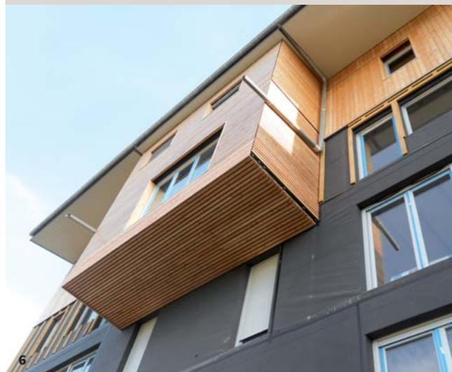
orientables pour lutter contre les surchauffes. La thermique est aussi parfaitement maîtrisée par la structure du mur, le choix des isolants et de leur performance. Le mur Cruard est une ossature de 145 mm isolée en ouate de cellulose, devant laquelle passe un isolant Acermi qui assure la rupture de ponts thermiques. Tous ces éléments ont été travaillés très en amont par le thermicien avec l'entreprise retenue lors du dialogue compétitif.
