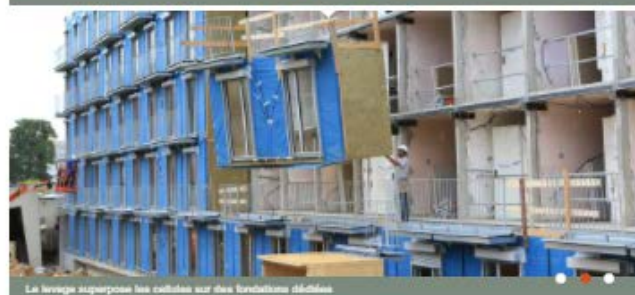
Le levage superpose les cellules sur des fondations dédoublées
