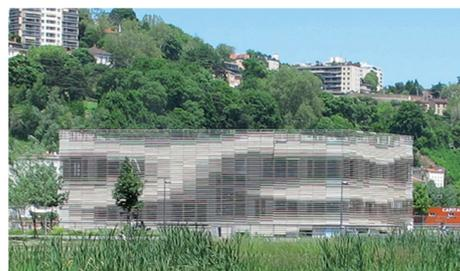
La peau de cet ouvrage, tout en ombre et en lumière, est constituée par la multiplication et l'inclinaison d'une simple planche de mélèze alpin, brute de sciage, aux dimensions 1250 x 155 x 28 mm. L'effet de vibration et d'ondulation a également été obtenu grâce à un traitement pré-grisé par des huiles naturelles.
