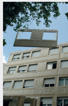
Levage des panneaux.
