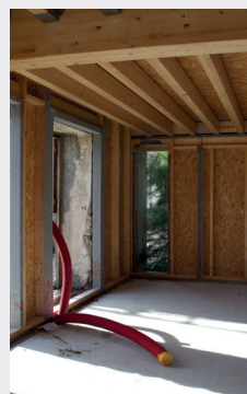
Ossature bois intérieure.
